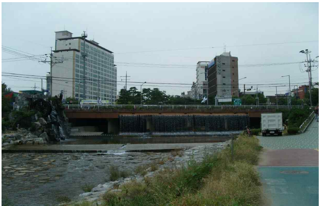
종점부 하부 전경
