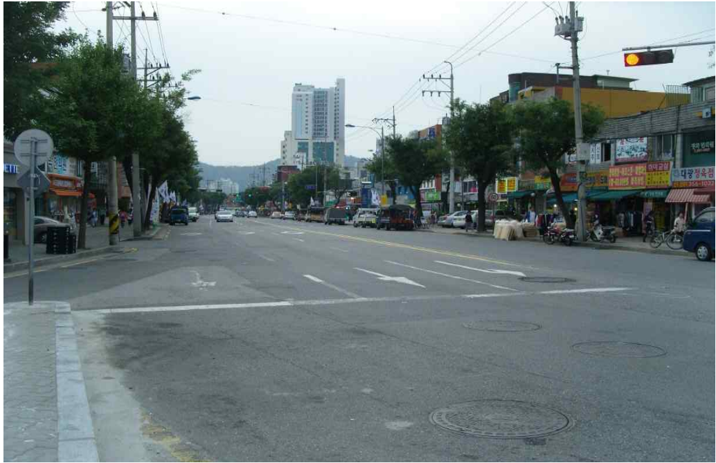
시점부 상부 전경
